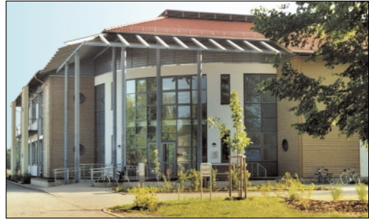
Abb. 44: Der im Sommer 2000 bezogene Laborneubau Genomzentrum hat wesentlich bessere Voraussetzungen für die Genomforschung geschaffen.
